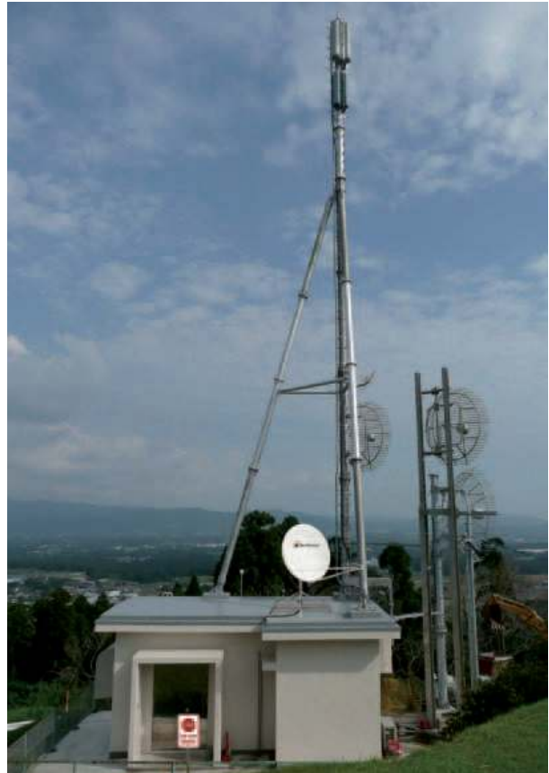
Fig. 1 - Installazione tipica di un Sistema Integrato Satellitare per il monitoraggio e la tele-gestione degli apparati di una stazione video broadcasting installata in un sito remoto
