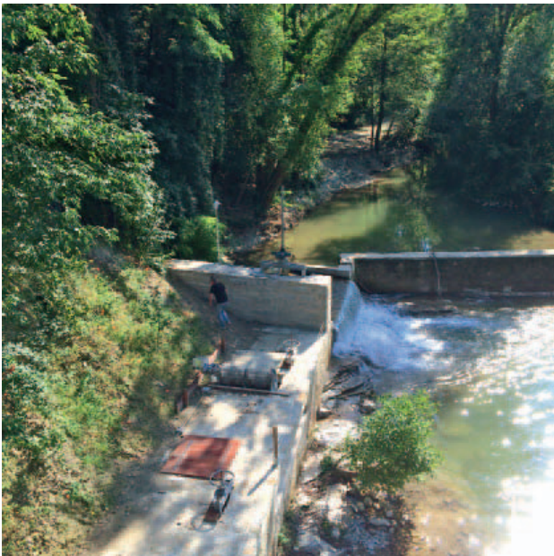
Il sistema di trasmissione dati via satellite implementato permette la comunicazione dati dai dispositivi installati alla centrale operativa
