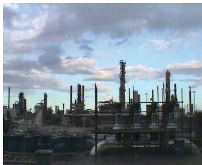
La soluzione è impiegata in una delle raffinerie Lukoil del polo petrolchimico di Siracusa
